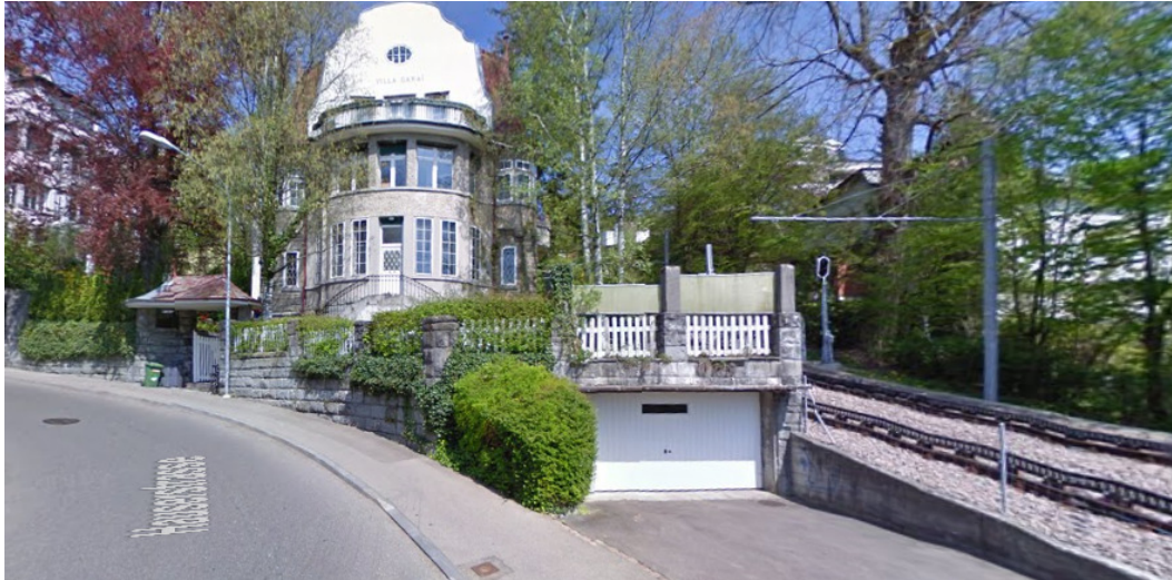
Wohnhaus Dolderburg, Hauserstr. 26, 8032 Zürich (2009)
